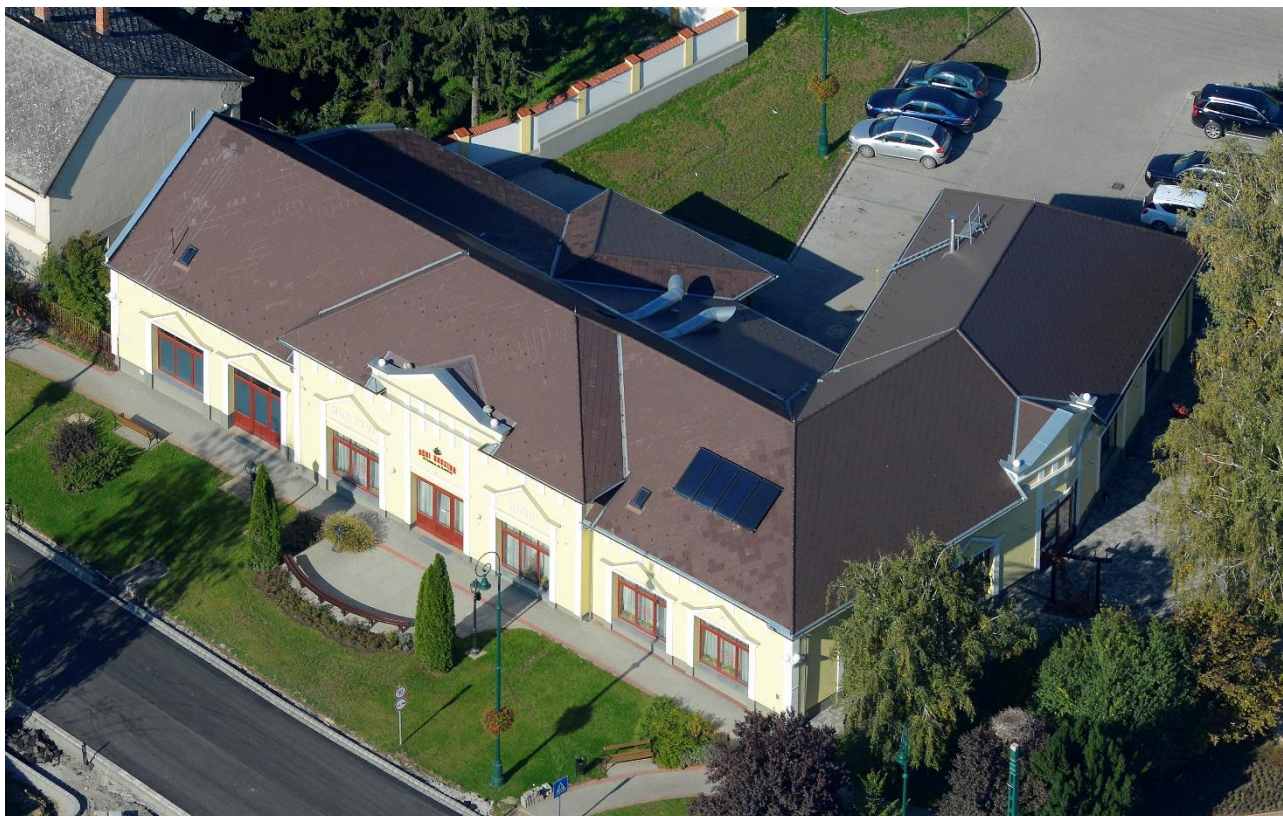
A RÉGI KASZINÓ ÉPÜLETÉN A KÜLÖNBÖZŐ GÉPÉSZETI BERENDEZÉSEK VAGY A TETŐZETBE BESIMULÓ MÓDON, VAGY AZ UTCAI HOMLOKZATRÓL LÁTHATATLANUL KERÜLTEK ELHELYEZÉSRE
