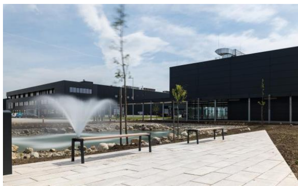
THYSSENKRUPP ÉPÜLETKOMPLEXUM ARÁNYOSAN TAGOLT ÉPÜLETE
