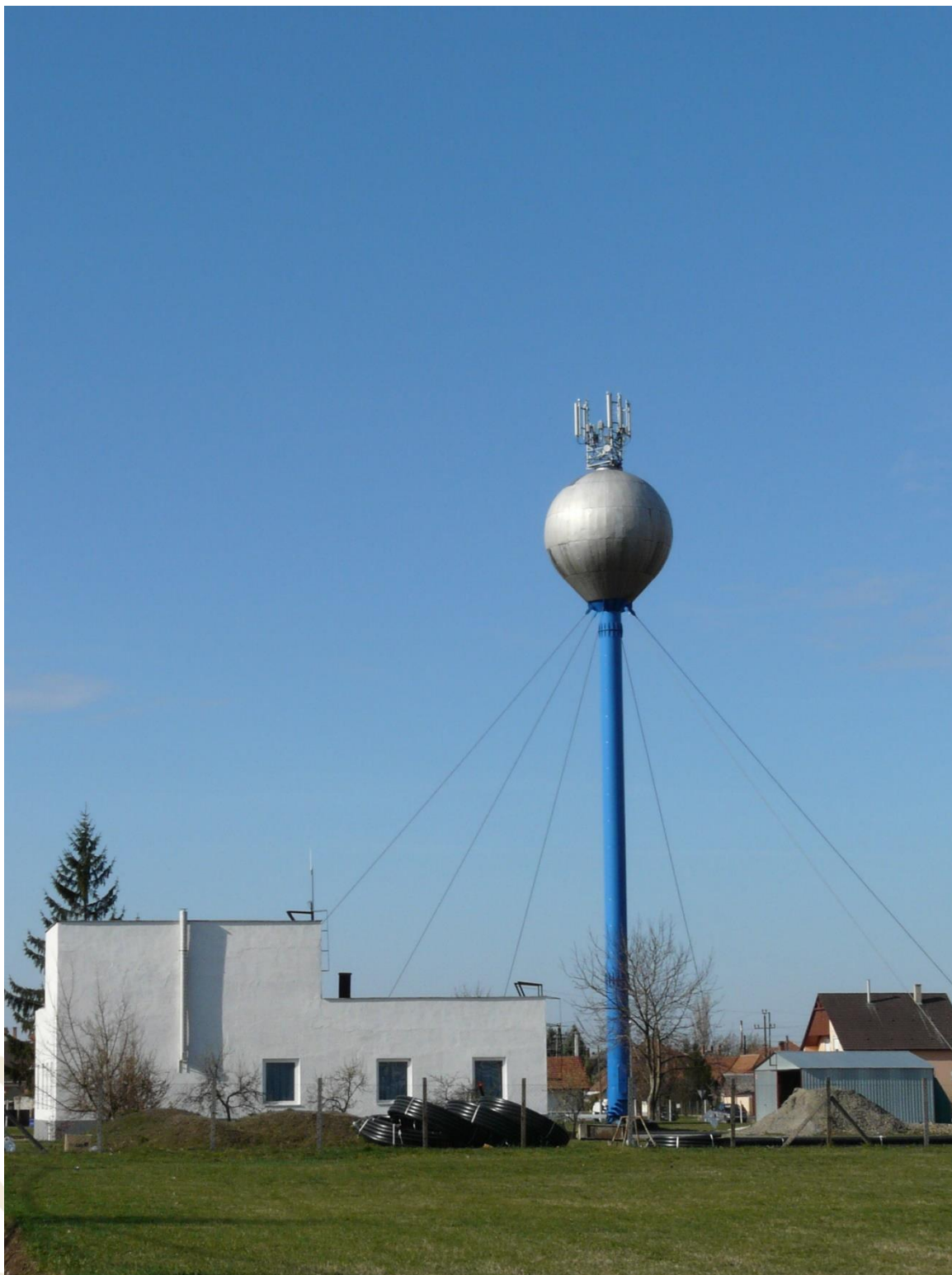
VÍZTORONY MARKÁNS ÉPÍTMÉNYTÖMEGE ÁTJÁTSZÓ ÁLLOMÁSOK TELEPÍTÉSÉRE IS IGÉNYBE VÉVE
