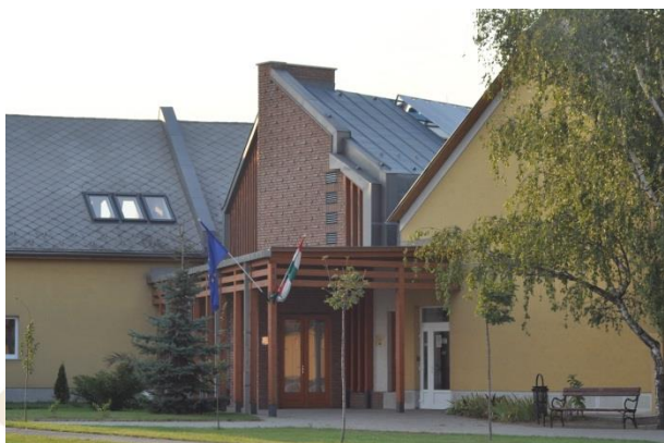
SÁRGÁ ISKOLA ILLESZKEDŐ ÖSSZEKÖTŐ ÉPÜLETRÉSZE
