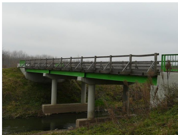
ZAGYVA FOLYÓ HÍDJA
