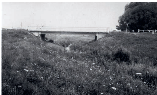
53. Zsámboki úti Galga-híd
