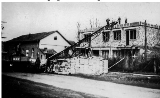
71. A Posta építése a volt Tüzeptelep helyére
