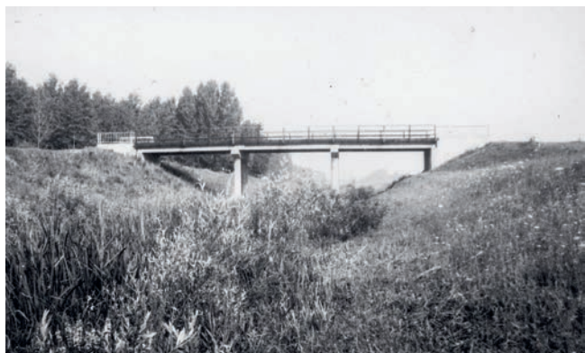
43. Almási úti Galga-híd
