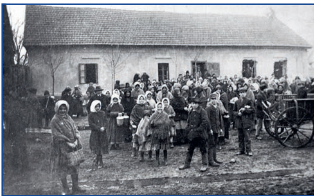
A jelenlegi helyén állt épület bontása, már az első két ablak kiszedve. A sokaság részben a bontás, illetve az épület előtt működő piac eladói vagy vásárlói. – 1925
