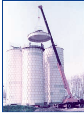
A Zöldmező telepen irányításával és brigádjával épült meg a 4 X 50 vagonos nedves kukoricatároló; az egyik siló kupolatetejének beemelése
