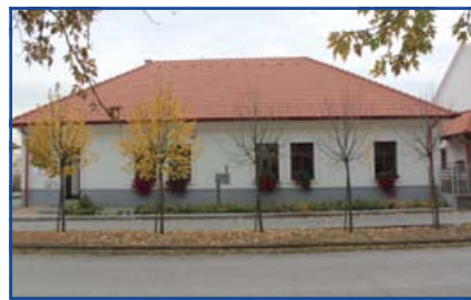
A régi parókia a felújítás után 2018-ban
