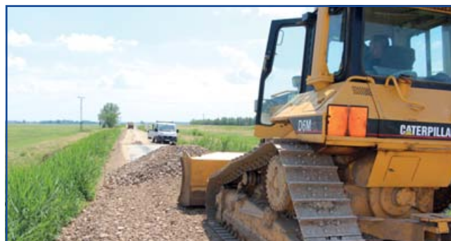
Épül a Zagyva-gáton a 3126 jelű összekötő út (Boldogi út) és a heves megyei határ között a kerékpárút a TOP-3-1-15-JN1-2016-00027 projekt keretében. Fotó: Illés Gergő
