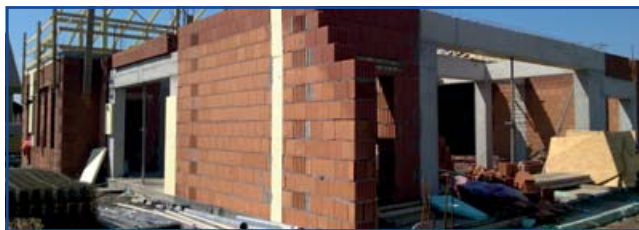
Friss képek az épülő új óvodáról. Fotó: Sugár Istvánné
