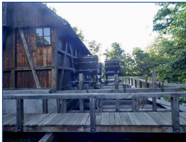
A túristvándi vízimalmot meghajtó három lapátkerék működés közben
