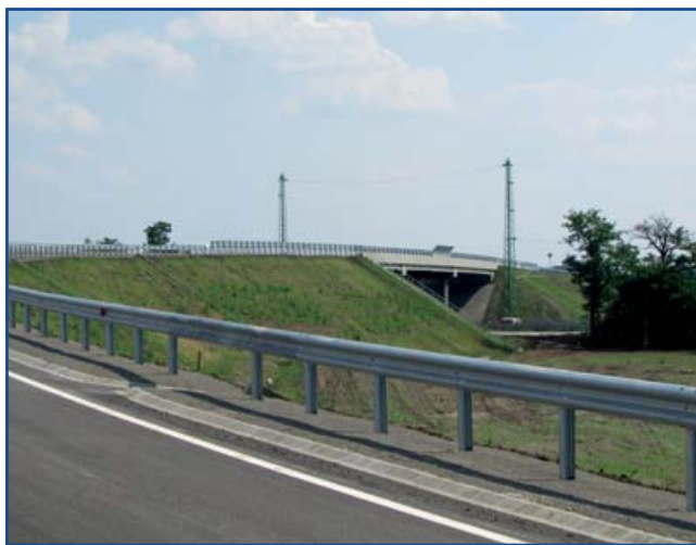
Az új közúti híd Jászfényszarunál
