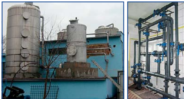
A Kemecei Vízmű arzénmentesítő egysége
