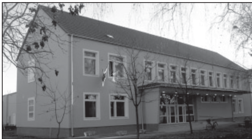
December 11-én került sor a Petőfi Művelődési Ház felújított épületének műszaki átadására.
