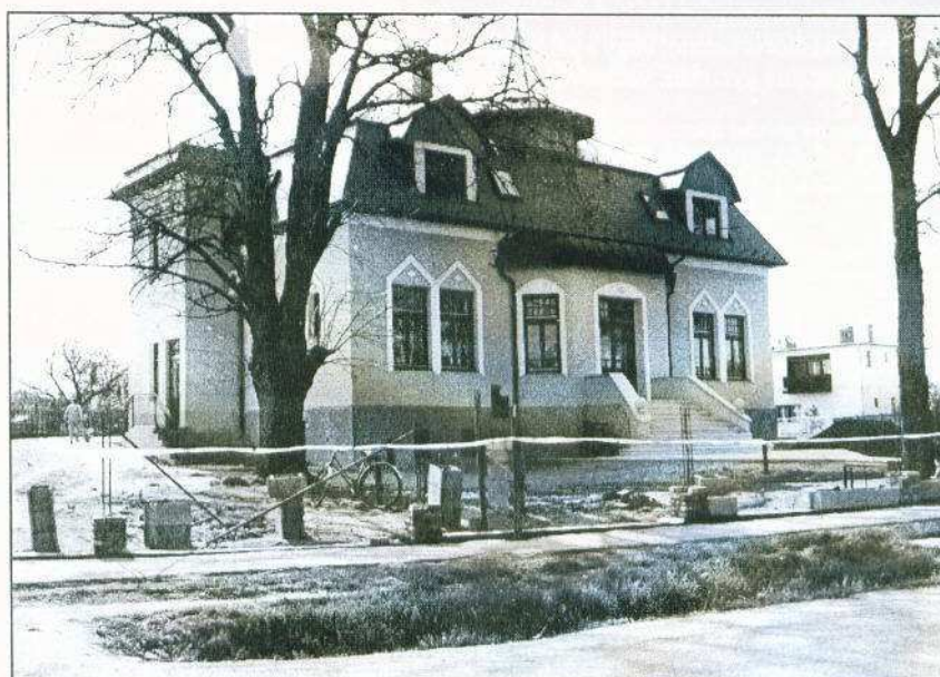
Folyamatban a kovácsoltvas kerítés építési munkálatai (Fotók: Sugár Judit)
